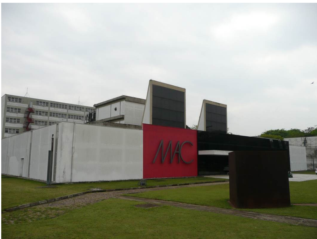
Figura 4.4 – Prédio principal do MAC
