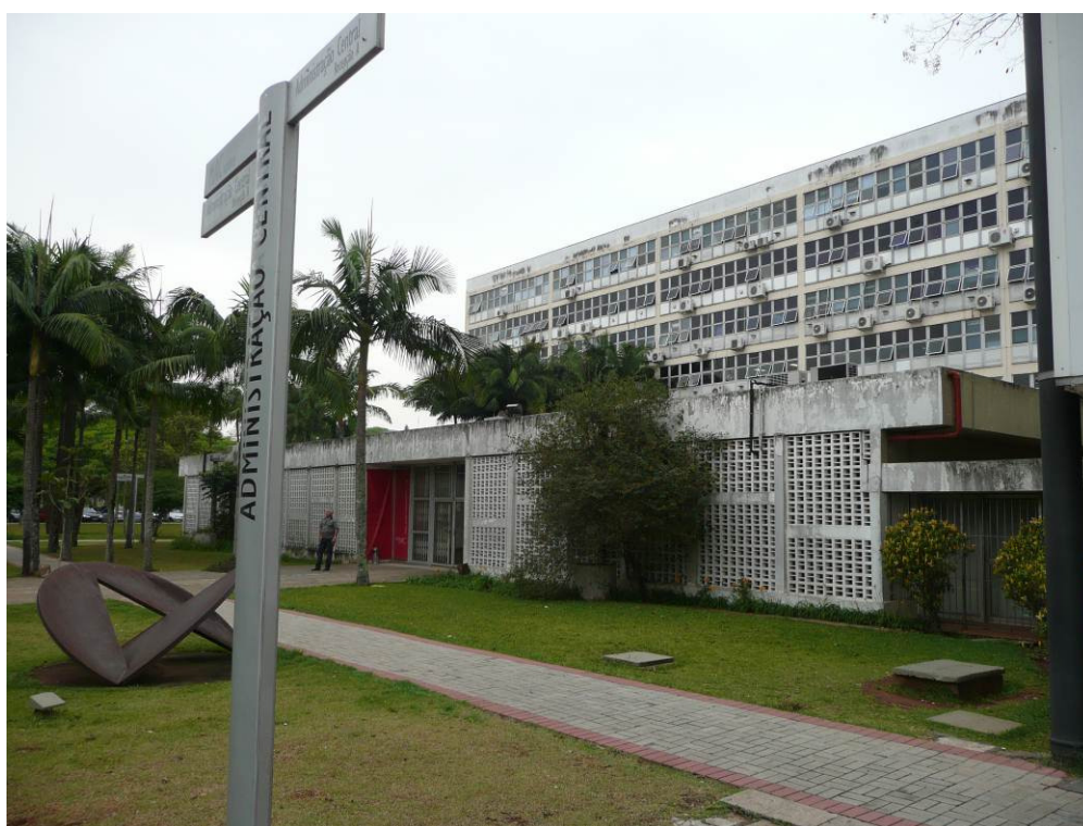
Figura 4.5 – Prédio anexo do MAC
